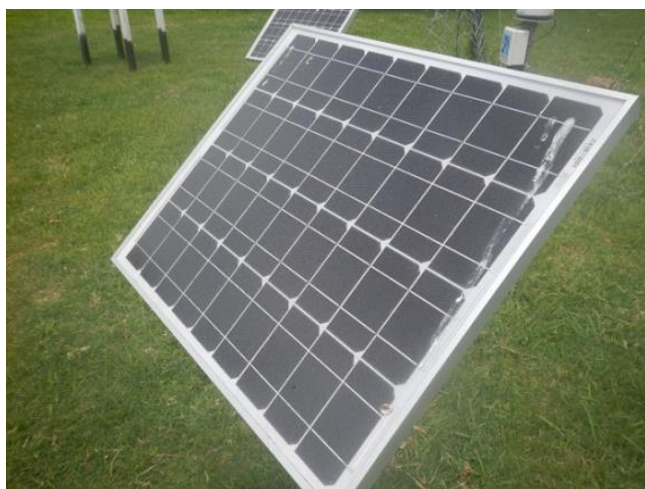
Figura 8: Panel sucio y su anclaje posterior con cable de corriente, los cuales requieren también inspección.
