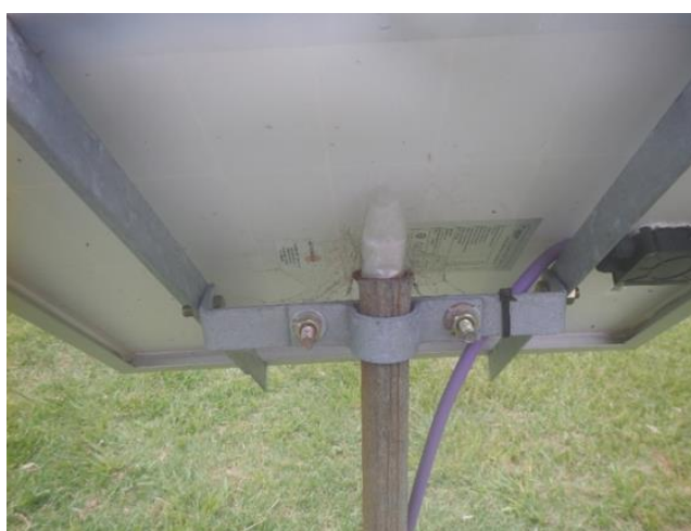
Figura 8: Panel sucio y su anclaje posterior con cable de corriente, los cuales requieren también inspección.
