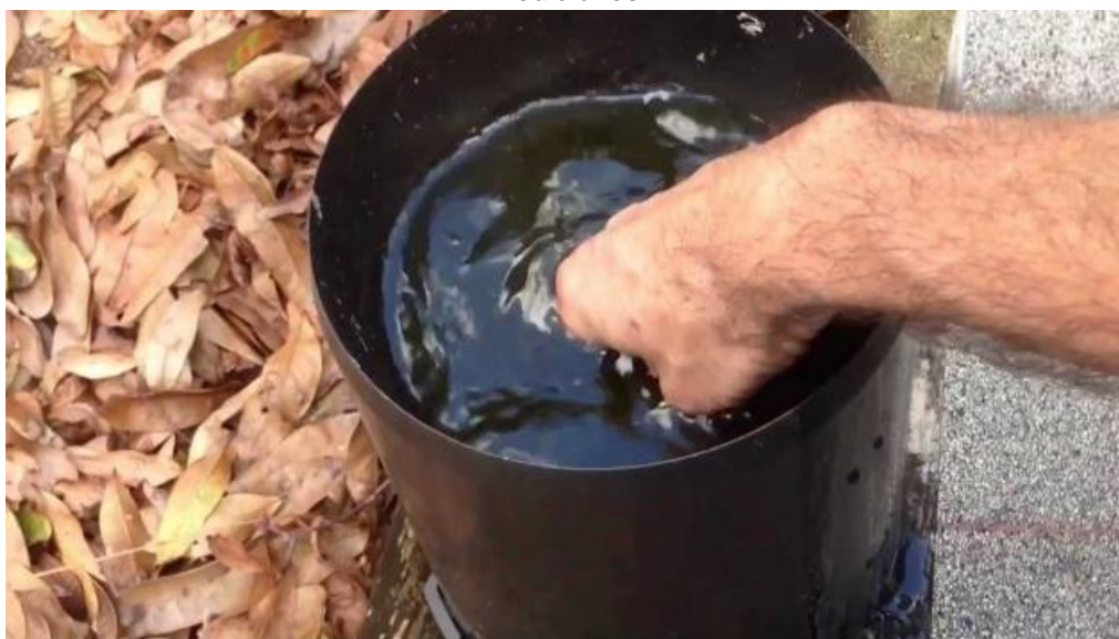
Figura 6: Retiro de hojas de la boca del embudo, las mismas bloquean el desagote.
