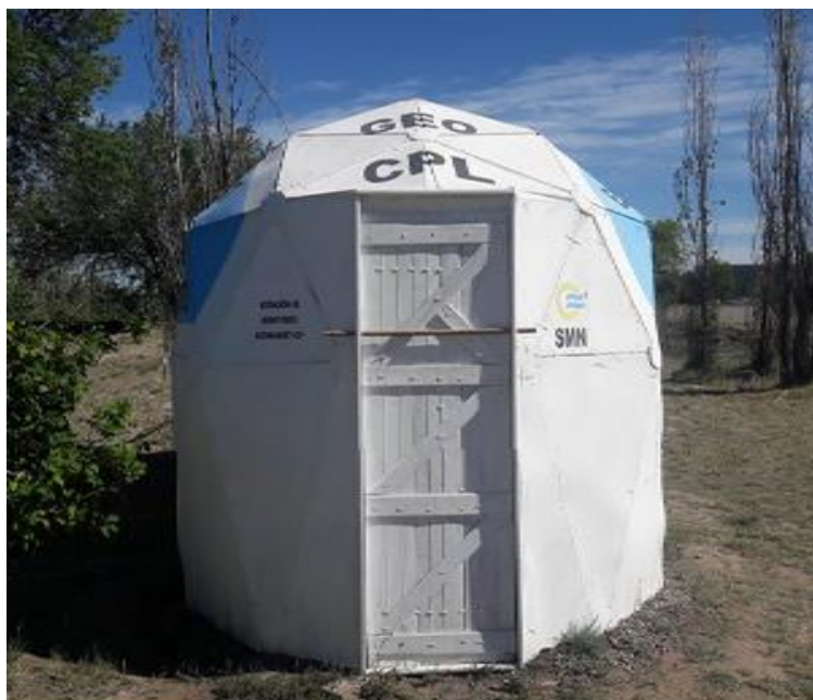
Figura 4: Casilla Geomagnética de la Estación CPL
